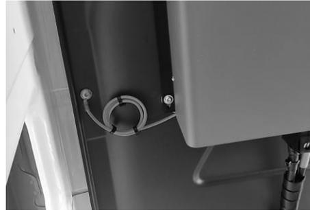
**Verzurren Sie das überschüssige Kabel mit Kabelbindern.**
